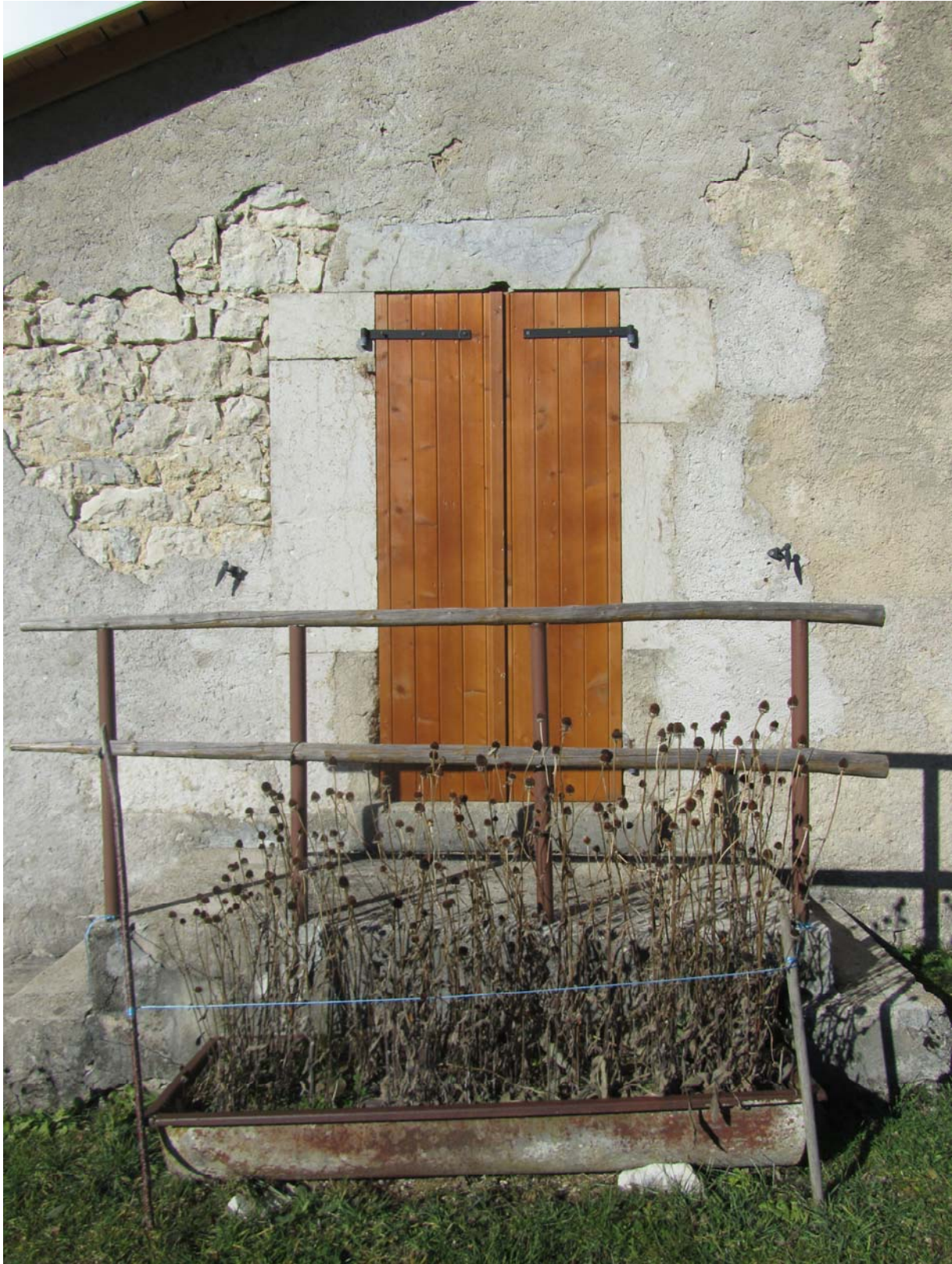
La porte d'entrée façade sud, soit au midi. Les pierres de taille de l'encadrement de la porte, idem pour les quatre fenêtres situées à droite de celle-ci, prouvent à l'évidence un bâtiment plus ancien entièrement restructuré.
