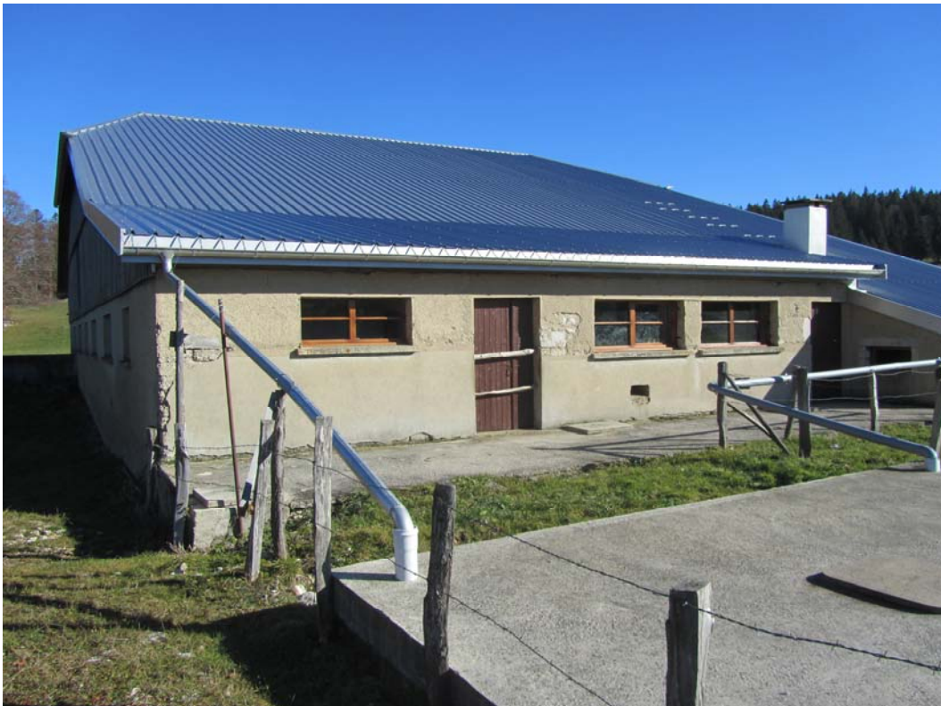
Les deux façades nord et ouest.
